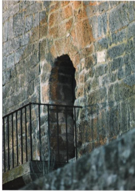
Figs.: Puerta de acceso elevado.
